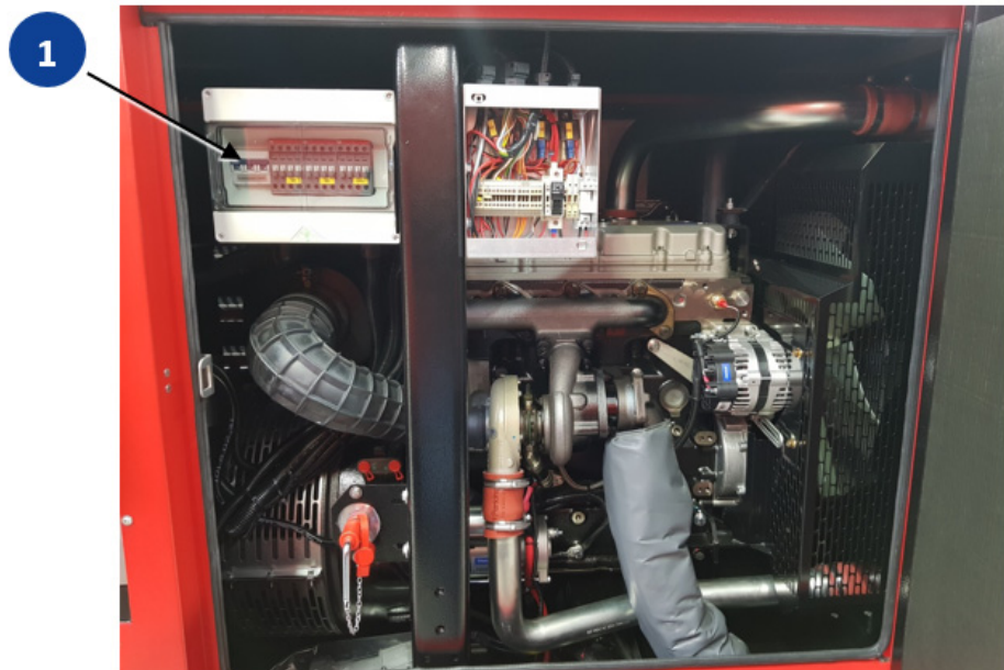
Abb. 7-3 Dummy Load Schutzschalter
